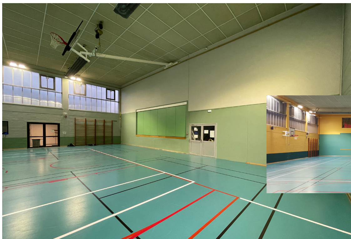
Gymnase en cours de rénovation
