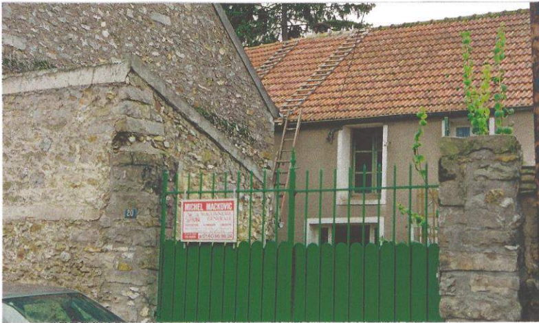
18 Volume ancien avec adjonction 19e en toiture hors typologie.
