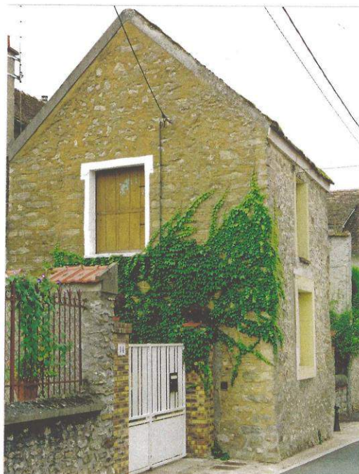
14-16 Constructions rurales anciennes en retrait sur rue, sauf le volume d'annexe en avancée sur l'alignement qui joue un rôle important de cadrage visuel de l'emprise publique (en vis-à-vis des annexes des 3 et 5). Petit volume en avancée sur la façade du 16 générateur de pittoresque. Gagnerait à la suppression de l'auvent protégeant la porte d'entrée. La parcelle du 16 fermée par un mur maçonné haut venant bien caler un apprentis en mitoyenneté.
