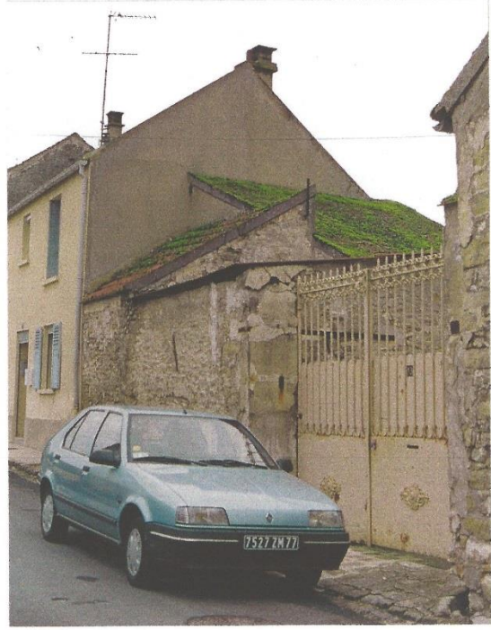
11bis Volume ancien en cours de restauration. Traitement incertain des détails.
