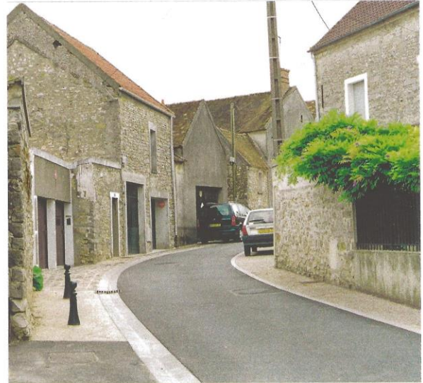
9bis - 11 Ensemble de deux maisons anciennes, partie d'un groupement se prolongeant jusqu'au 15, elles aussi implantées en retrait sur rue. Figuraient sur le cadastre de 1826 avec des annexes sur rue aujourd'hui démolies. Murs anciens heureusement conservés au droit du 9bis. Groupe de deux garages modernes dommageable après l'entrée du 11.
