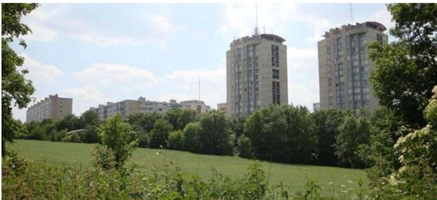
Le quartier de l'Almont, vue des « Belles Vues » Chemin du Coudray Meneraux.
