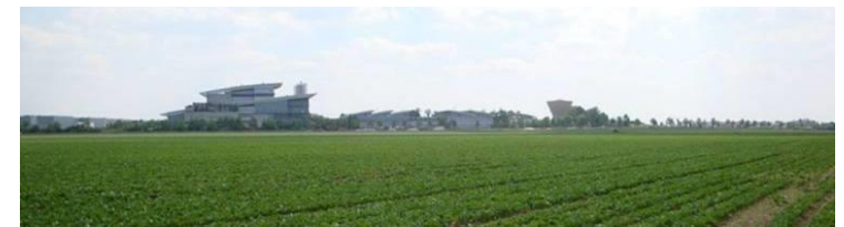
L'imposante silhouette de la plate forme sur la RD 408 vue des « Belles Vues », Rue de Melun
