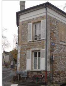
Par exemple : ce type de façade ne peut pas recevoir une isolation par l'extérieur
