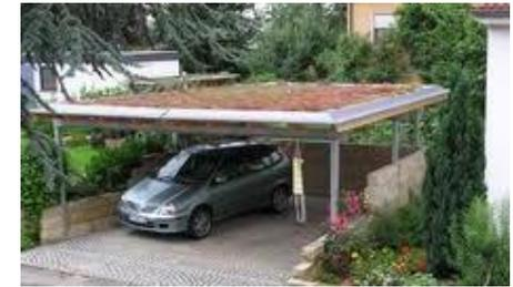
Pour les futures constructions, en cas de toiture plate la végétalisation permettra d'offrir une vue agréable pour les étages supérieurs. La toiture végétalisée possède des qualités d'isolation thermique et phonique, elle retient également les eaux pluviales de manière temporaire ce qui en cas d'orage permet de différer les rejets dans les réseaux. Les espèces adaptées qui y sont implantées viennent enrichir la biodiversité.
