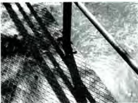
En 1958, des décisions d'entretien hasardeuses avaient défiguré le pont, remplaçant le bois par des éléments industriels constitués de plaques de métal quadrillées et de tubes métalliques.
